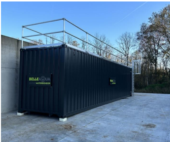
Figuur 18 BelleAqua - zuiveringscontainer
