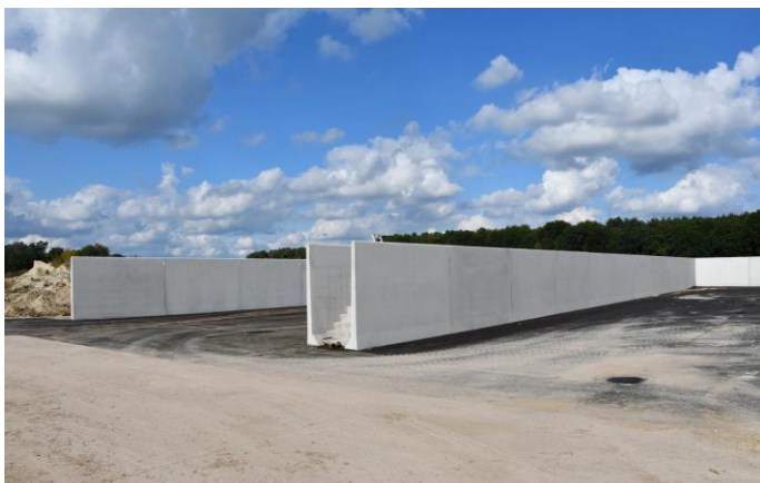
Figuur 9 CBS beton - sleufsilo
