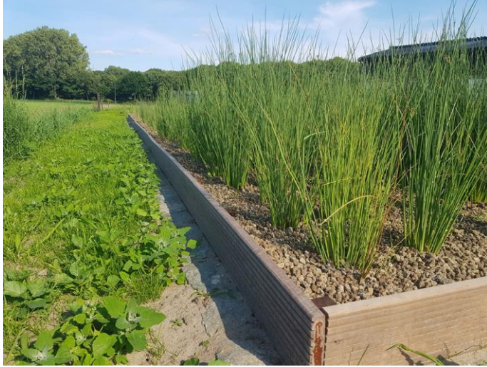
Figuur 19 Proper Afvalwater - Waterzuiveringssysteem
