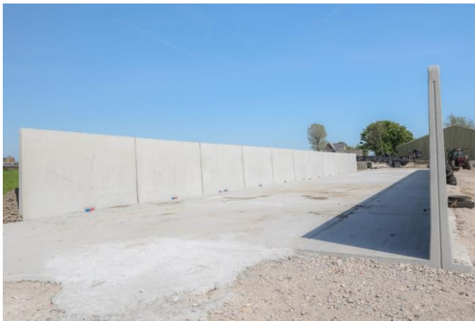
Figuur 8 Bosh Beton sleufsilo
