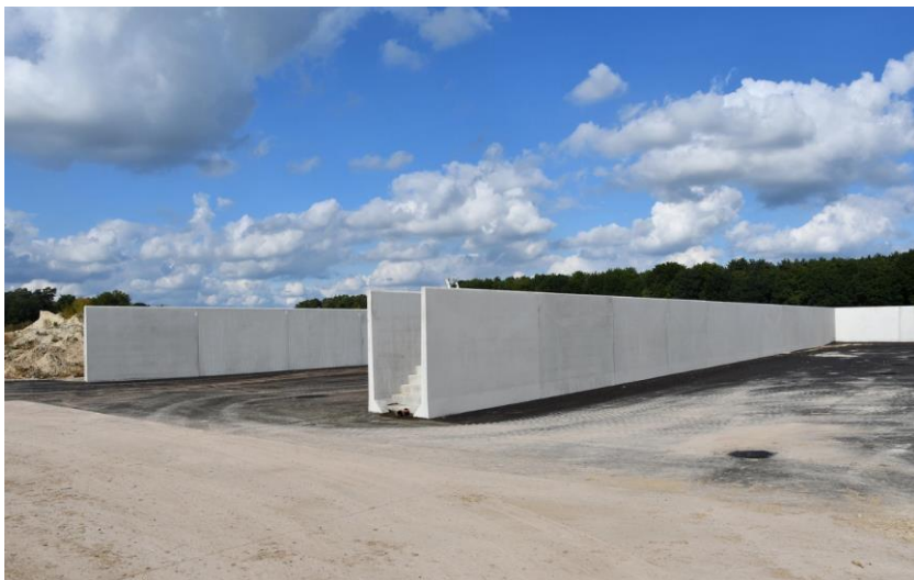
Figuur 8. CBS beton – sleufsilo
