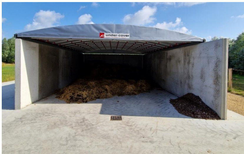
Figuur 17. 2Cover - Overkapping mestopslag met schuifbaar systeem
