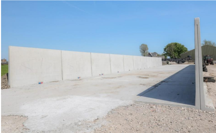
Figuur 7. Bosh Beton sleufsilo
