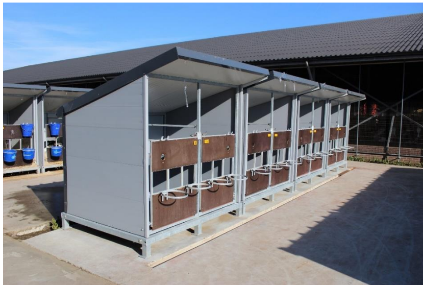
Figuur 13. AB-Loonconstruct kalverhok Op een hellend betonplein waarbij regenwater en mestwater gescheiden afgevoerd wordt.
